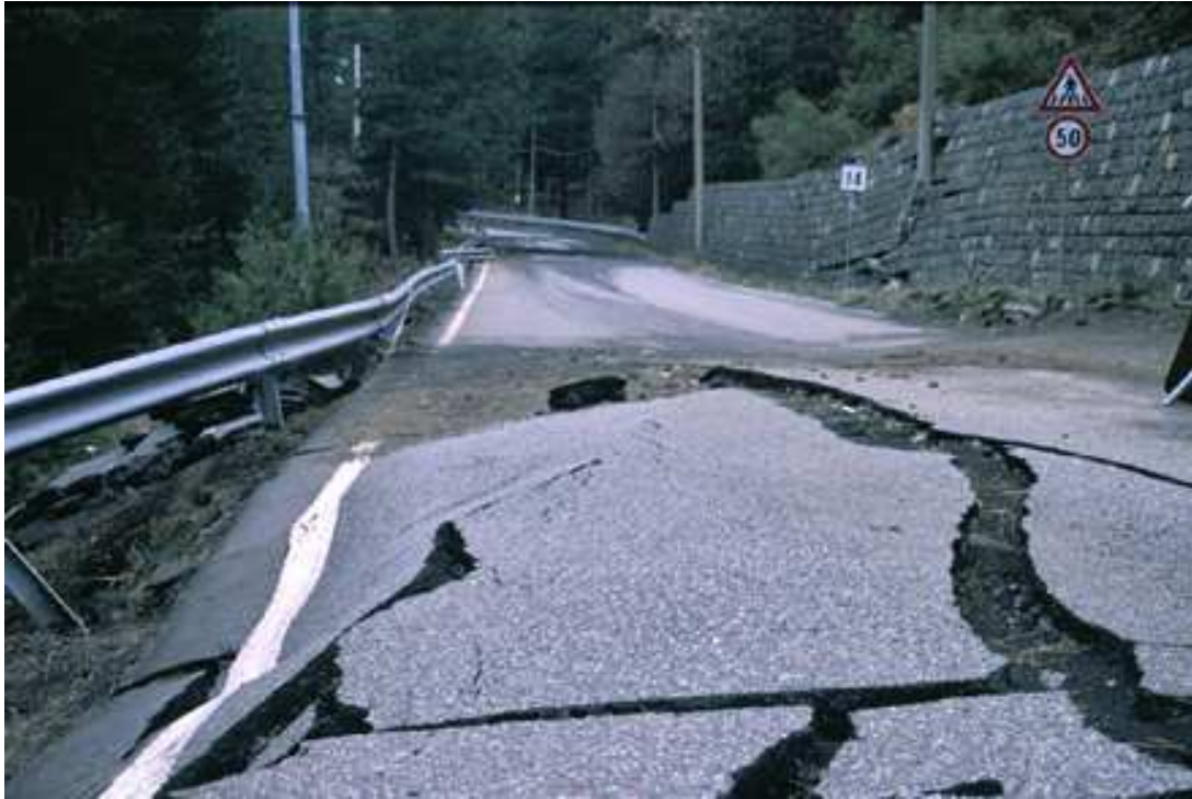
Route endommagée par un séisme de M 4,3 sur les pentes de l'Etna
